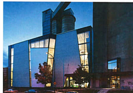
Le centre d'escalade Allez up a été construit dans les silos de l'ancienne usine Redpath.
